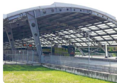
Stazione della metropolitana di Affori Milano
